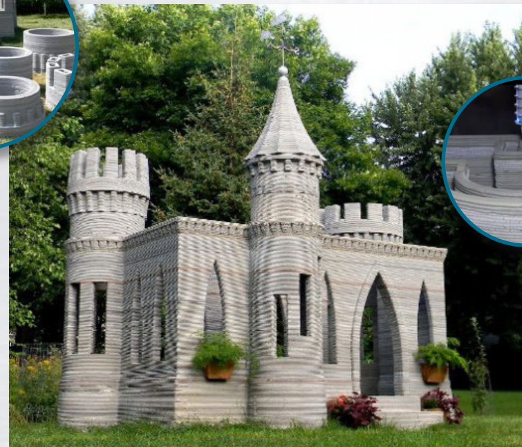
Met beton geprint kasteeltje
