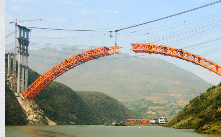
Brug in aanbouw
